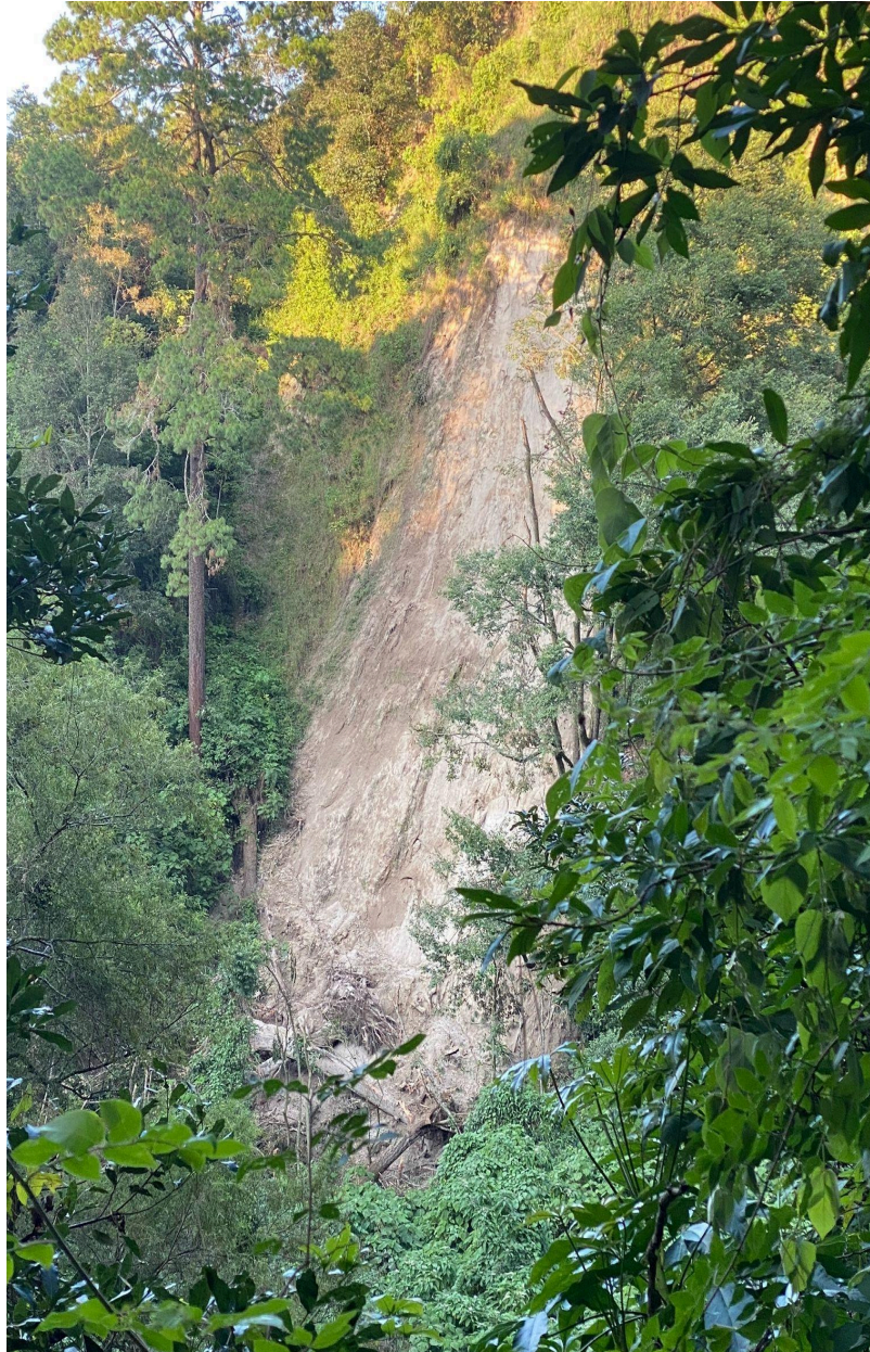
Imagen 5: fotografía del terreno privado donde se obtuvo la Licencia Ambiental EAI-5322-2023, se observa deslizamiento de tierra de grandes proporciones.
